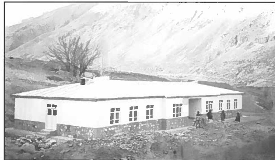
Her ser vi Hazrat Said gutte- og jenteskole. Denne er oppført i 1998 med en god del av arbeidet utført som dugnadsinnsats fra lokalbefolkningen. NAC har med hjelp av midler fra OD 96 bidratt med: sement, armering, tømmer, blikktak og vinduene. Arbeidet har vært ledet av NAC.
